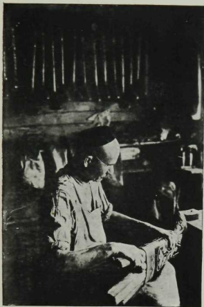
Посадка ичег на колодку мастером Каримом Гизатуллиным (Казань, 1927 г.) Из материалов П. Дульского.
